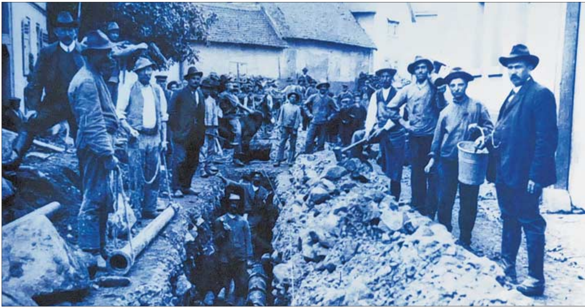
Bei den Wasserleitungs- und Kanalarbeiten in den Jahren 1907/08 in der Giessener Straße in Watzenborn-Steinberg waren viele helfende Hände erforderlich. Diese ersetzen bei Arbeiten dieser Art die heute üblichen großen Baumaschinen. Bilder/Repro: M. Bender
