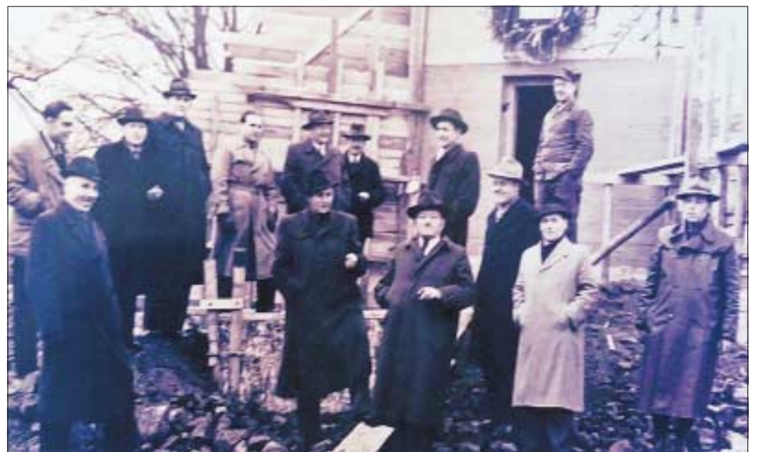
Richtfest am Hochbehälter „Auf dem Trieb“.
